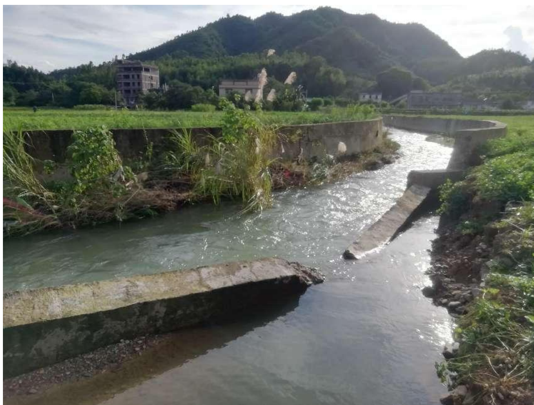
图 11.2.2 护岸遭洪水冲毁现状图
