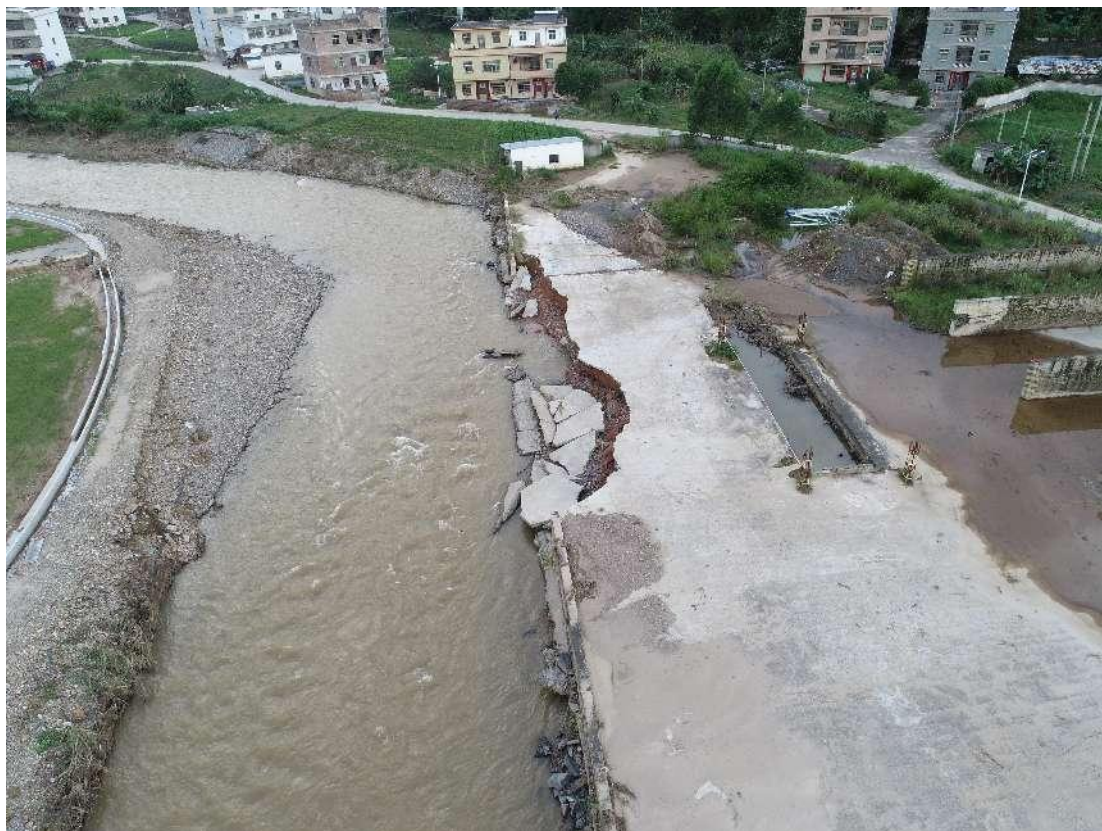
图 11.2.1 护岸遭洪水冲毁现状图
